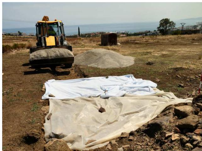
**CUBRICIÓN CON GEOTEXTIL DEL SONDEO 11 EN EL YACIMIENTO ROMANO**
