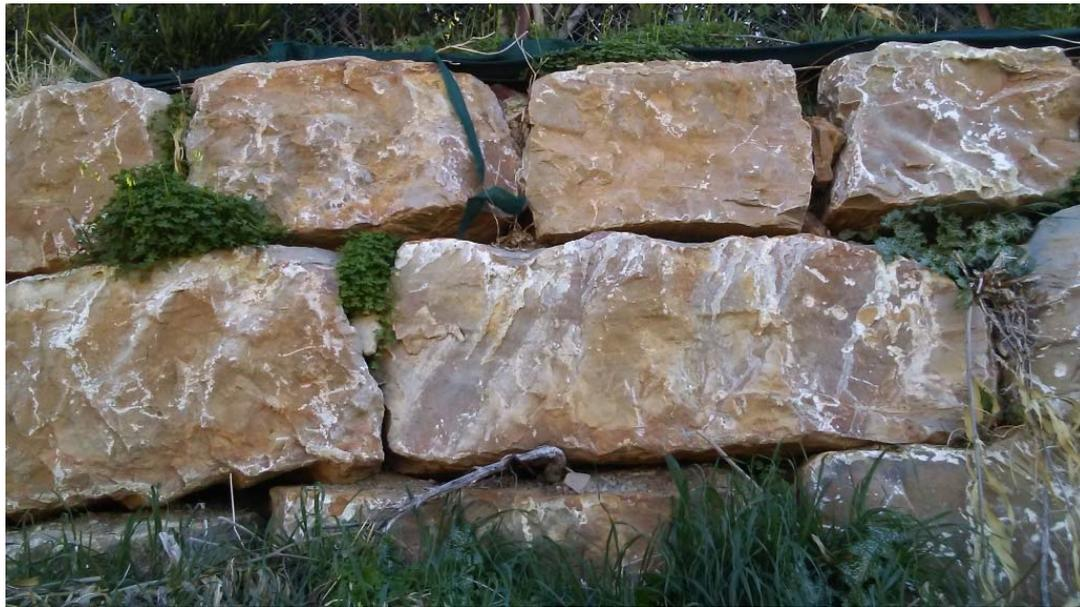
Figura Nº 13.- Muro de escollera existente.
